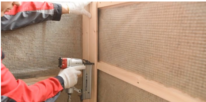
Рис. 7. Устройство внутренней обшивки
