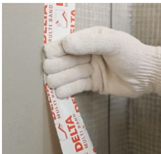
Рис. 12. Проклейка примыканий пароизоляции к стенам и окну
