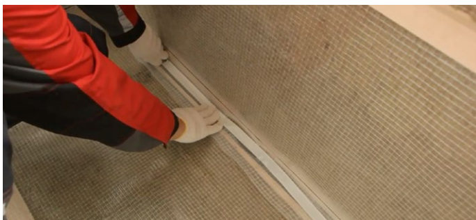
Рис.11. Проклейка нахлестов пароизоляции
