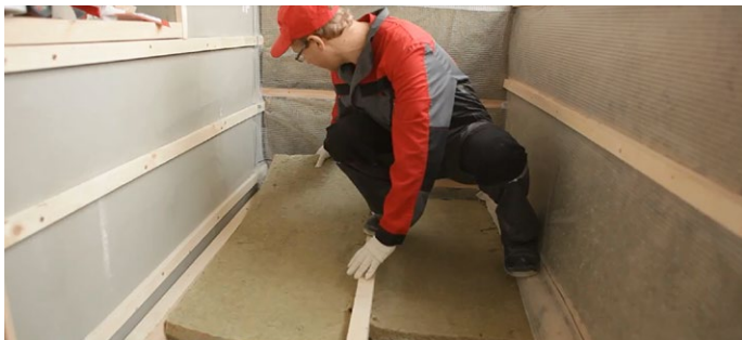
Рис. 9 Укладка теплоизоляционных плит
