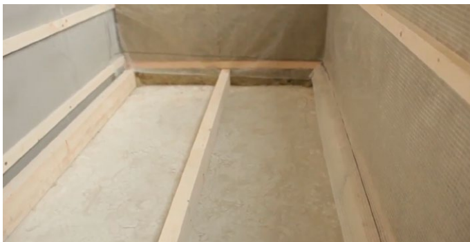
Рис. 8. Монтаж деревянных лаг на пол
