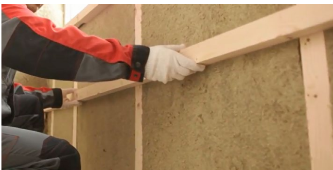
Рис. 3. Установка горизонтального каркаса под теплоизоляцию
