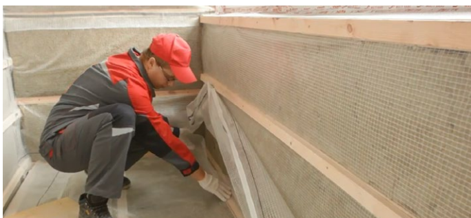
Рис. 10. Монтаж пароизоляционной пленки
