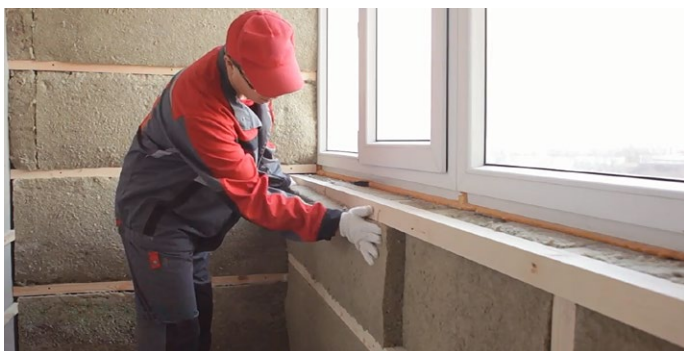
Рис. 4. Укладка плит теплоизоляции второго слоя
