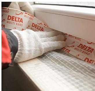
Рис. 12. Проклейка примыканий пароизоляции к стенам и окну
