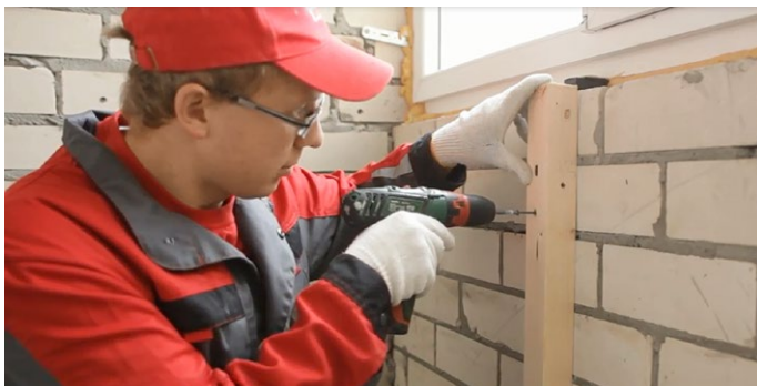
Рис. 1. Установка вертикального каркаса под теплоизоляцию
