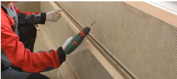
Рис. 6. Монтаж контррейки
