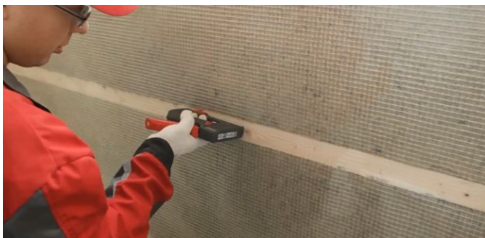
Рис.5. Монтаж пароизоляции
