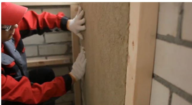
Рис. 2. Укладка плит теплоизоляции первого слоя
